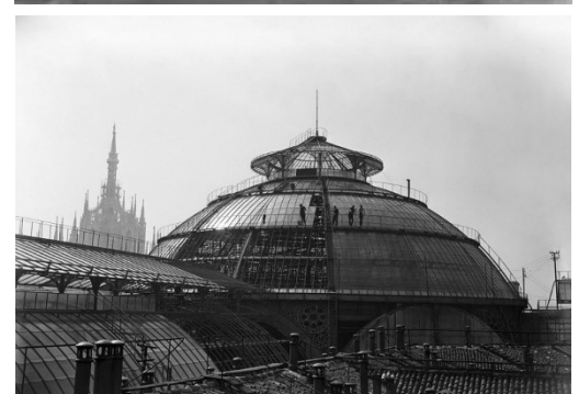
Lavori di ricostruzione, 1948
